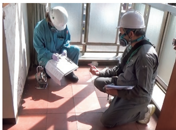
建材を採取して層の確認方法を解説。
