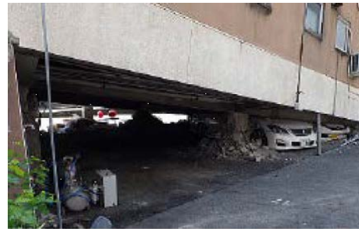
同左 ピロティとして利用されていた
