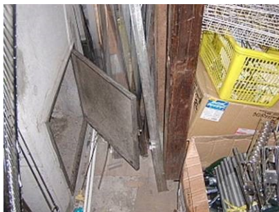
写真 A 点検口
