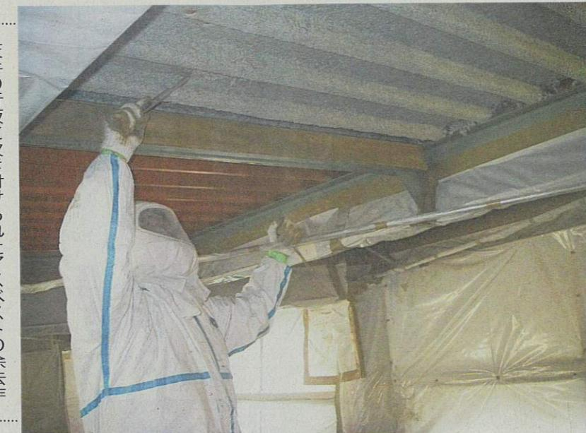
天井の折板に吹き付けられたアスベストの除去作業。外部への飛散防止のため密閉空間にし、防じんマスクや防護服などを着用して作業する。そぎ落としたアスベストは固化処理される。折板には薬剤処理を施し残っている可能性のあるアスベス
